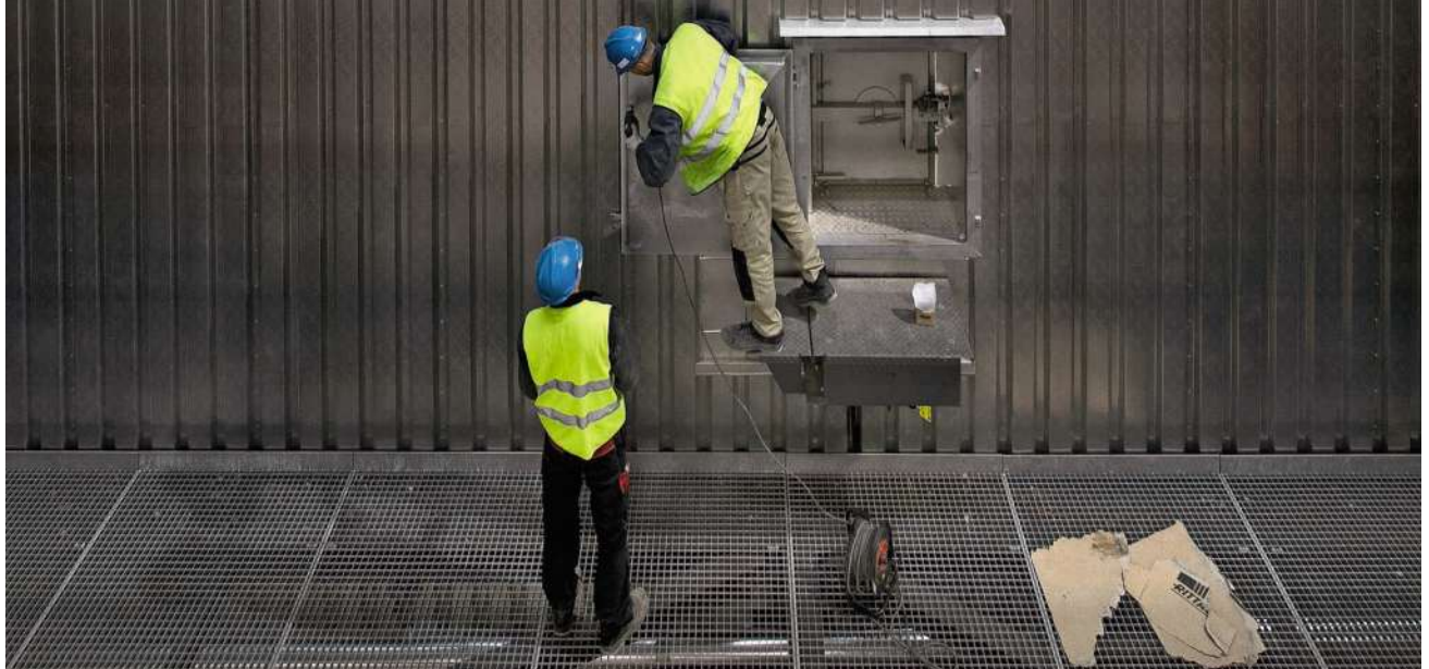
Die neue Kehrichtverbrennungsanlage in Root ist die grösste Industriebaustelle der Zentralschweiz.
